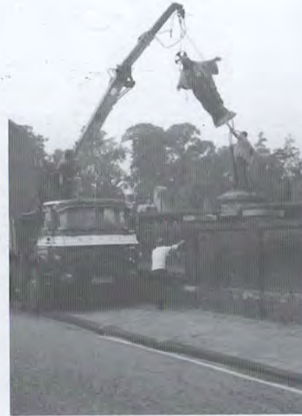
1969. Het H.Hartbeeld wordt terug op zijn sokkel geplaatst.
