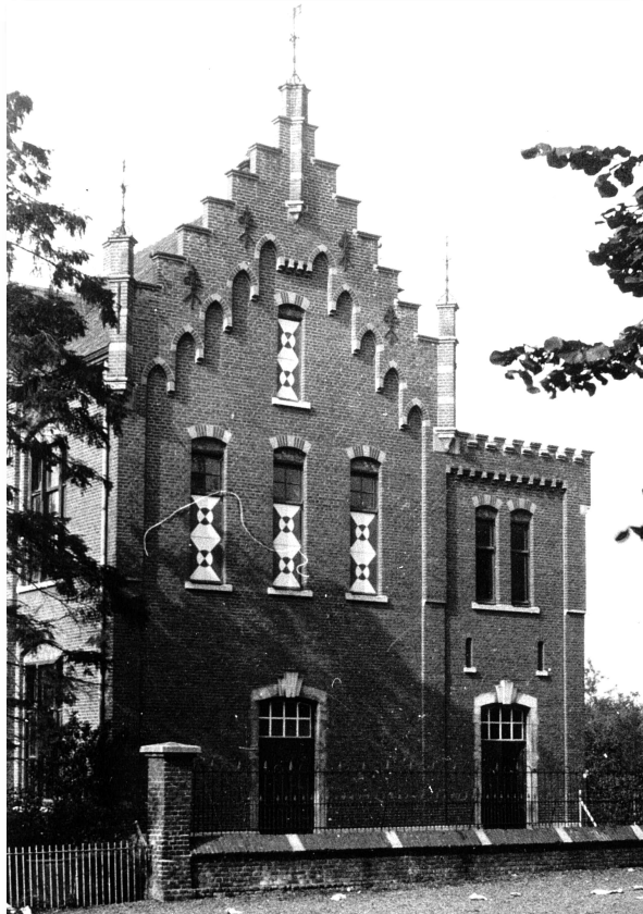
Voorgevel verbouwde school
