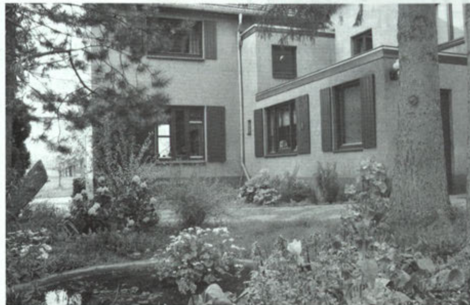
De bovenstaande "achteröm" ligt niet aan een doorgaande weg. Het huis is wel duidelijk zichtbaar.
