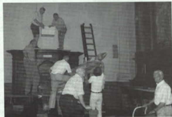
2005. Start renovatie kerk.
