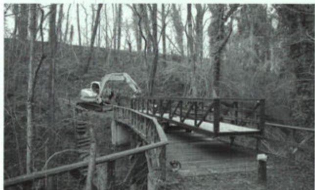
2005. De nieuwe brug wordt over de oude heen op haar plaats gerold.
