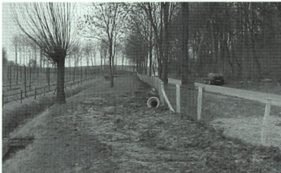
Het eindresultaat van de werkzaamheden. Een ingang van een dassentunnel en een stevige afrastering langs de Sint-Geertruideweg. (foto Arcadis)
