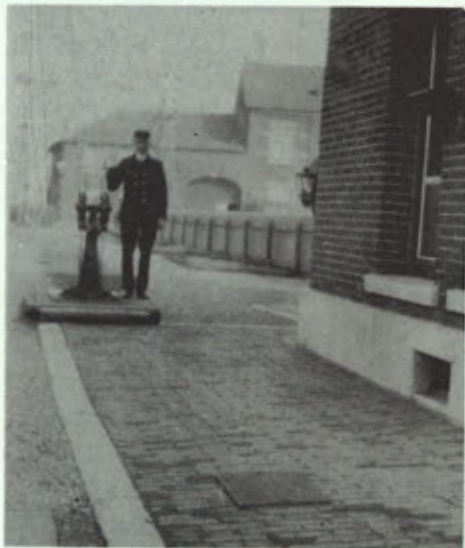
Rond 1930. Jan op het perron van station Gronsveld, bij het apparaat dat op afstand de spoorbomen bediende.
